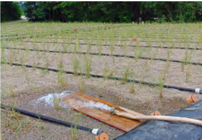
Große Kraft: Der Bodenfilter besteht aus mehreren Kiesschichten und Schilfbepflanzung. Nach der biologischen Reinigung kommt hygienisch sauberes Wasser heraus.
